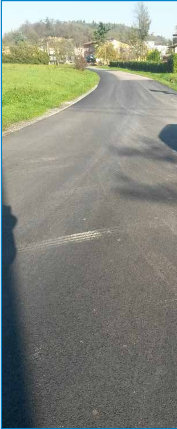
La riasfaltatura di via Caossea", sistemata dopo tanti anni in lunghi tratti
