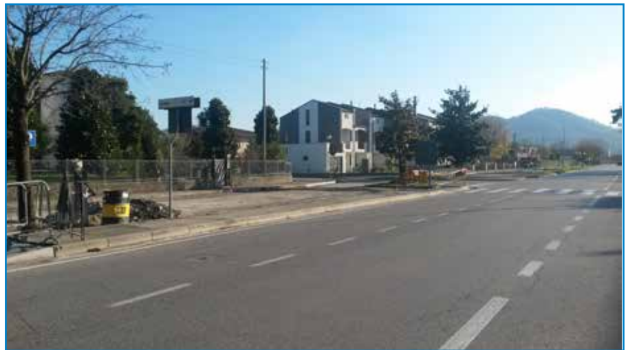
Il rifacimento dei parcheggi di via Castelletto
